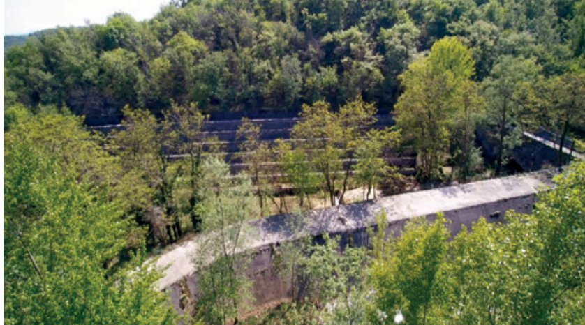
Località Torondon , bacino di calma e gradoni dello sfioratore
