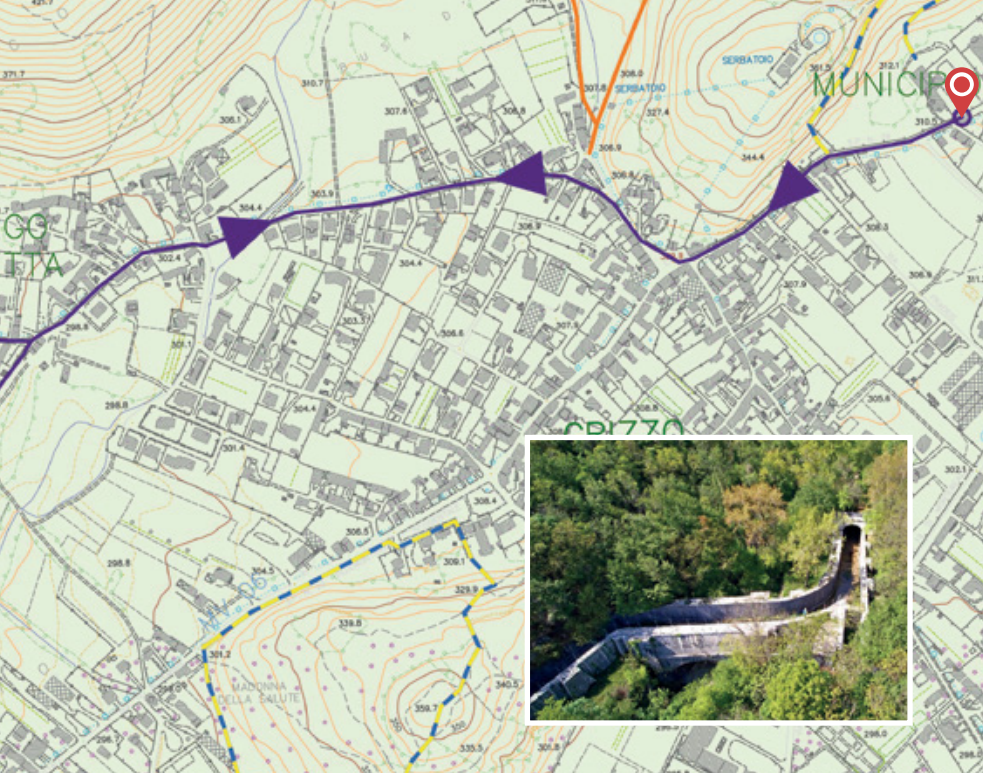
Località Chiasarile , galleria e ponte-canale
