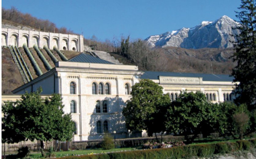
Malnisio, centrale idroelettrica "Antonio Pitter"
